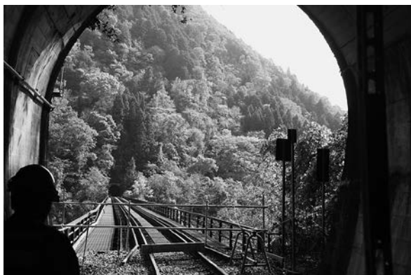
三江線廃線跡トロッコ実験実験でトンネルから見る江の川鉄橋
