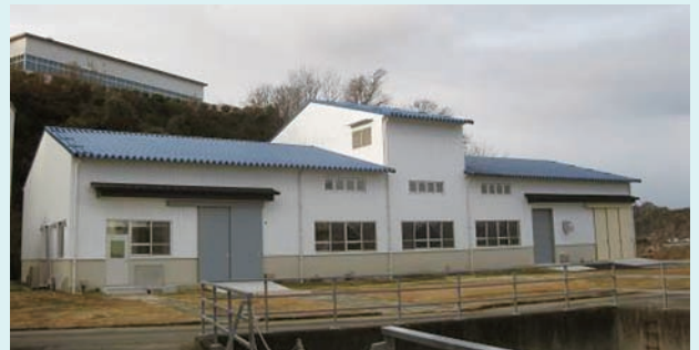
船舶総合実験棟
